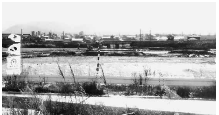
草野地内工業団地造成工事現場
