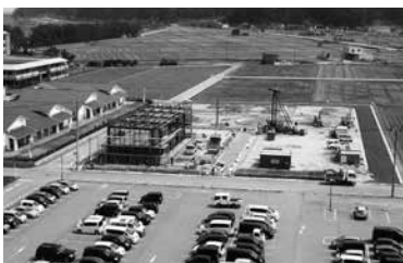
医療・福祉従事者の住宅アパート建設工事
