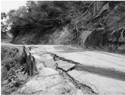
雨により崩落した町道湯ノ瀬北又線（災害復旧事業として補正予算を可決）
