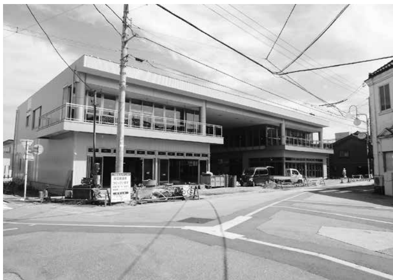
建設中の五差路周辺複合施設
