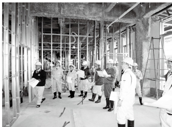
五差路周辺複合施設現地調査
