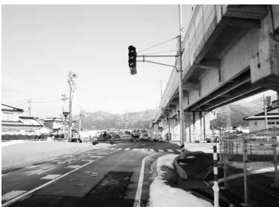
信号が移設された基幹農道と県道朝日宇奈月線の交差点
