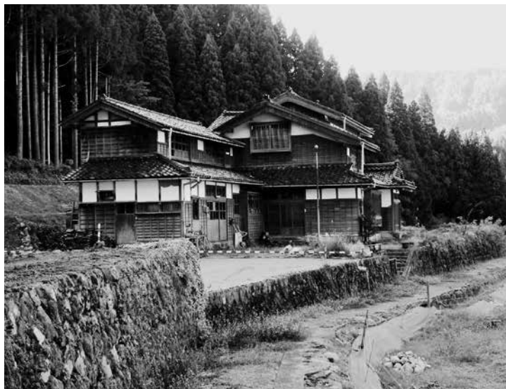
「ふるさと交流拠点施設」となる古民家（笹川地内）
