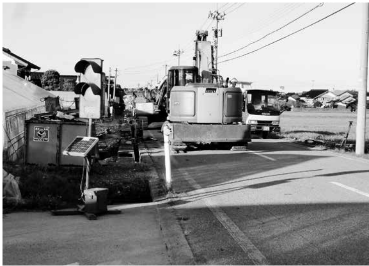
下水道工事の様子（三枚橋地内）
