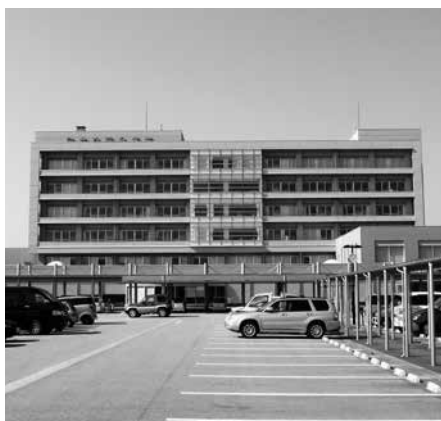
あさひ総合病院外観
