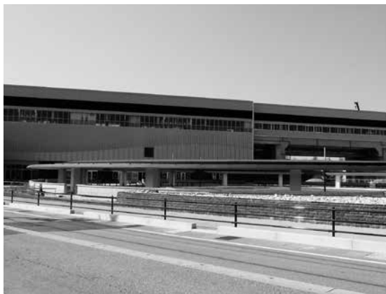
建設中の黒部宇奈月温泉駅
