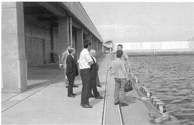
直接接岸して荷卸しできる構造の人工島「Mランド」(室蘭市)
