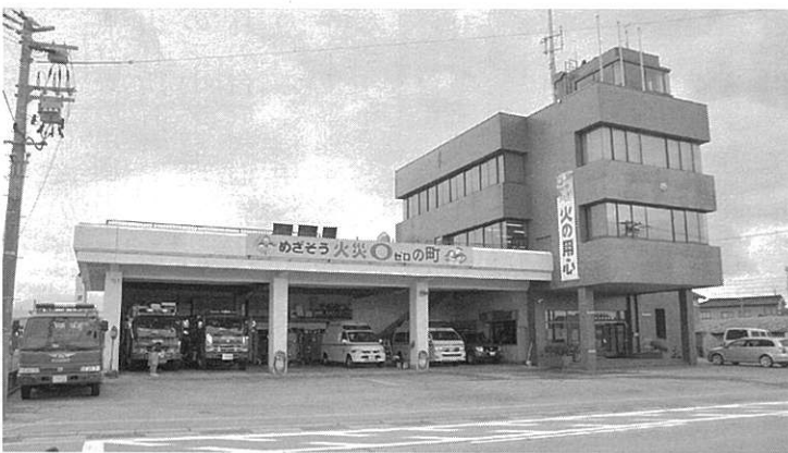
昭和53年に建設された現在の消防庁舎
