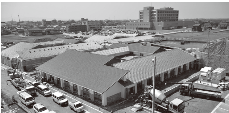
有磯苑の増床工事
