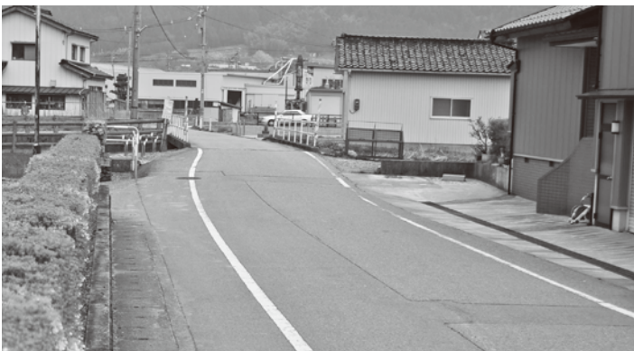
町道道下沼保線の木流川橋梁付近
