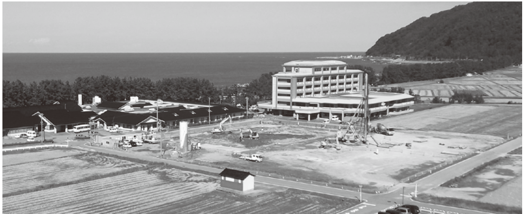
建設が進められる有磯苑の増築工事
