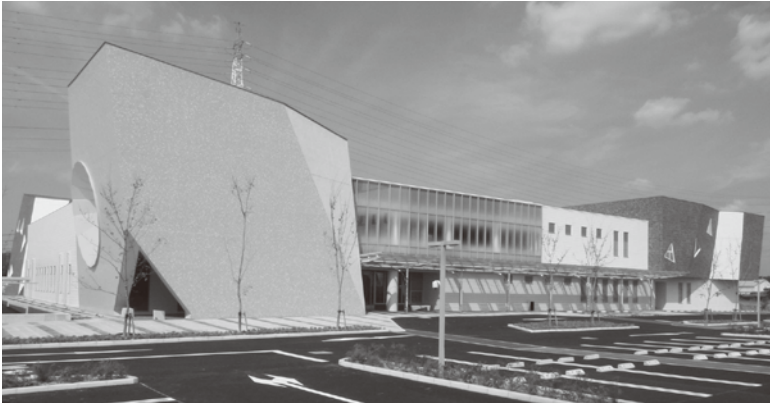
日進市立図書館 外観
