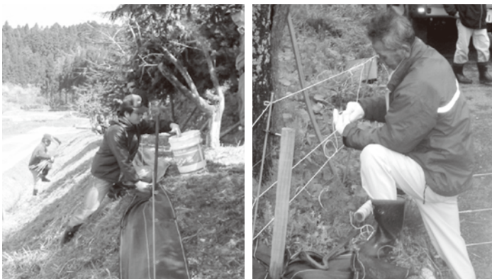
電気柵の設置作業
