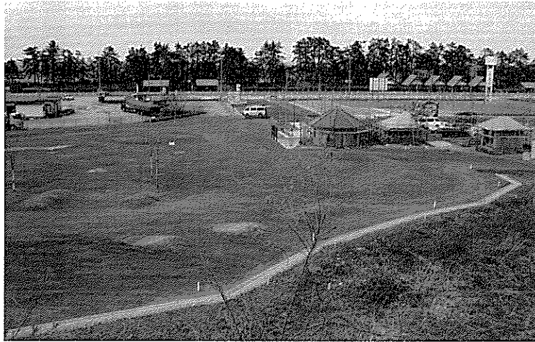
建設中のパークゴルフ場
