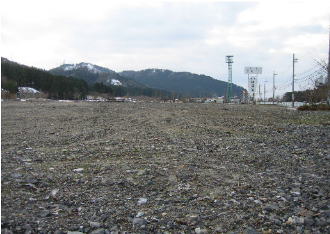
建設工事が進められているパークゴルフ場用地
