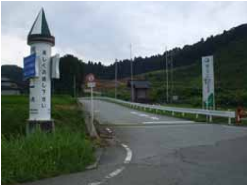
路線の一部が林道に変更されることとなった町道棚山線
