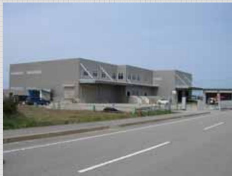
舟川新地内に建設中の新工場
