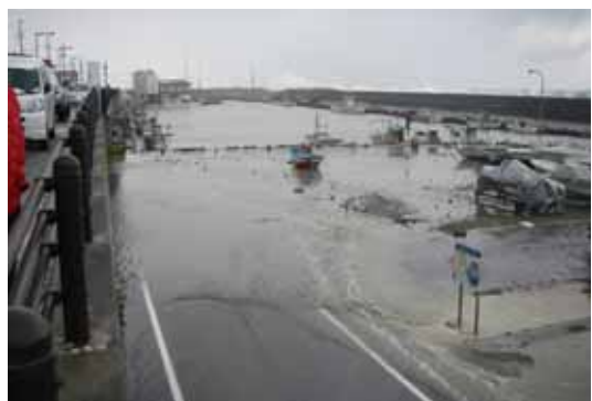
高波により冠水した宮崎漁港内の道路
