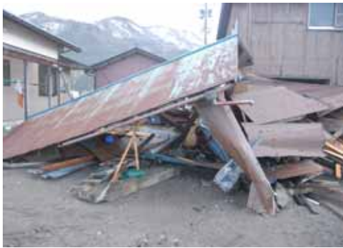
高波により倒壊した作業小屋
