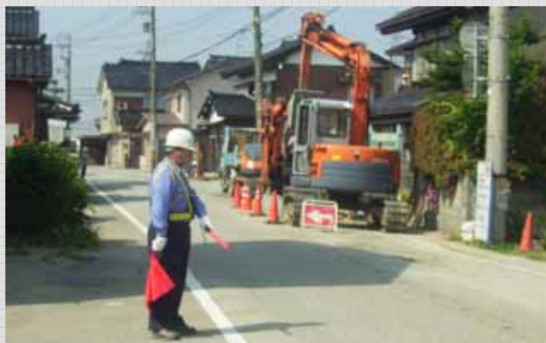
平柳・道下地内の下水道工事
