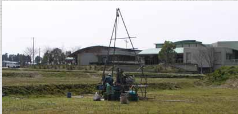
新保育所建設予定地で行われているボーリング調査
