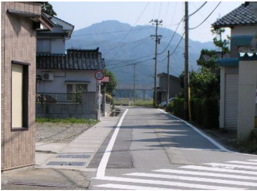
一部暗渠化された県道山崎草野線(桜町地内)
