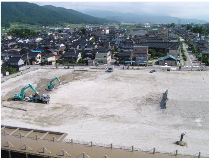
あさひ総合病院前の駐車場整備現場
