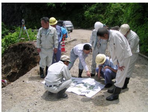
町道湯の瀬北又線災害復旧現場
