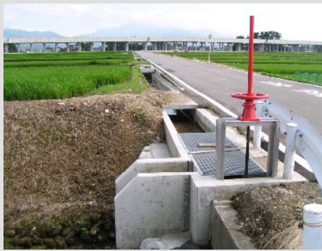
土地改良事業で行われた用水の改修工事
