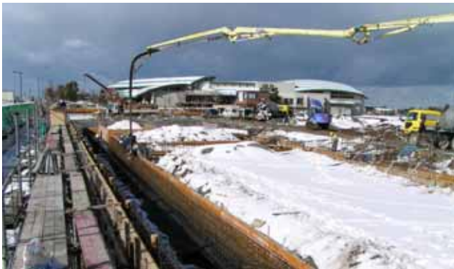
建設中のあさひ野小学校屋外プール
