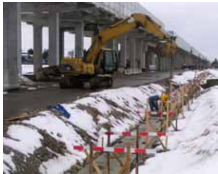
広域農免農道工事現場
