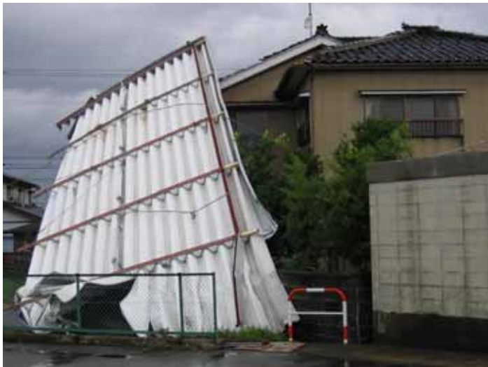
台風18号による被害
