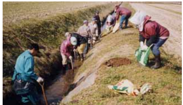
農業用排水路の維持管理状況
