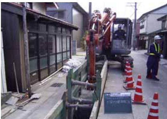
下水道工事の状況
