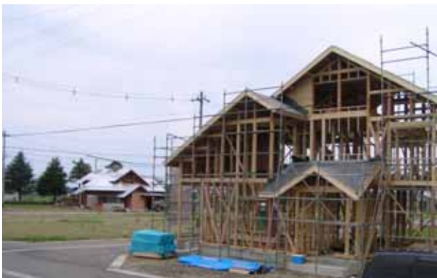
よこお団地に新築中の住宅
