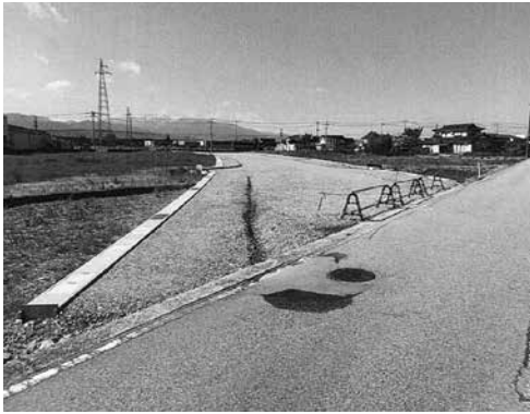
区域内の道路整備の様子
