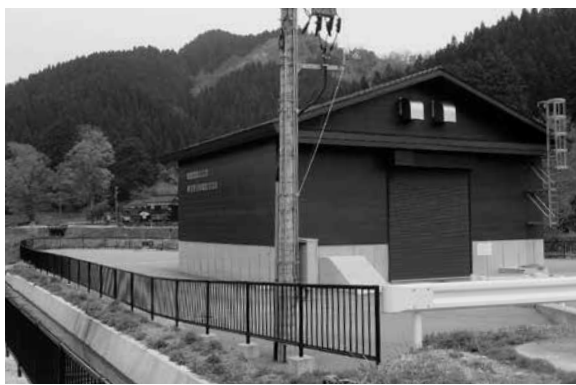
小水力発電所（小川用水発電所）
