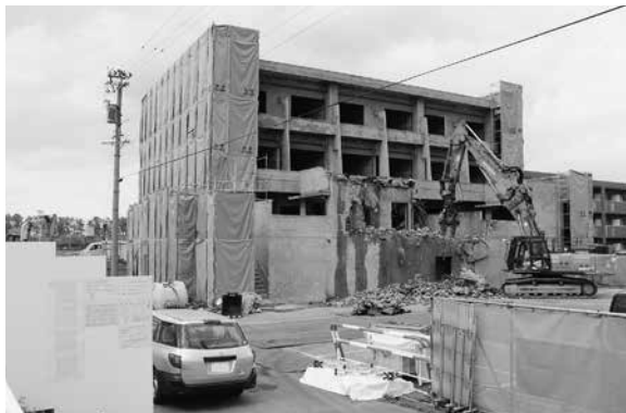
解体が進む病院旧官舎
