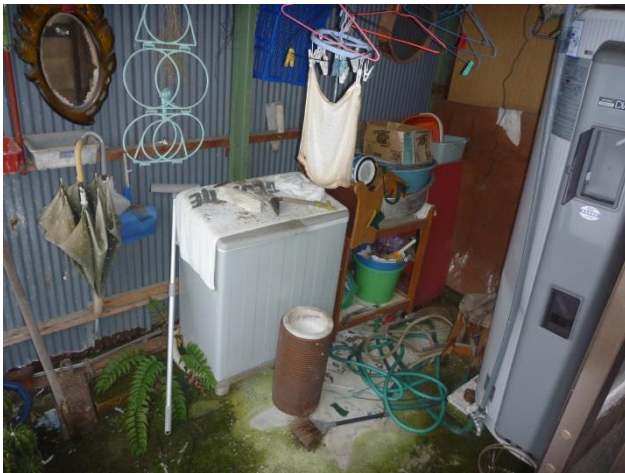
1階 ボイラー、物置
