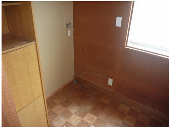
1階 洗濯機置場
