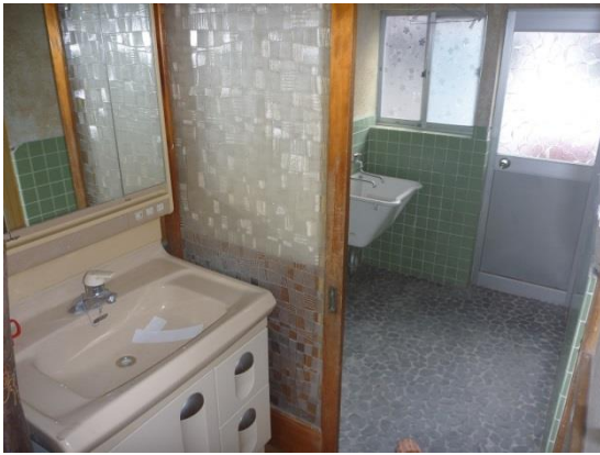
洗面台・洗濯機置場
