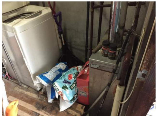
1階 洗濯機、ボイラー置場
