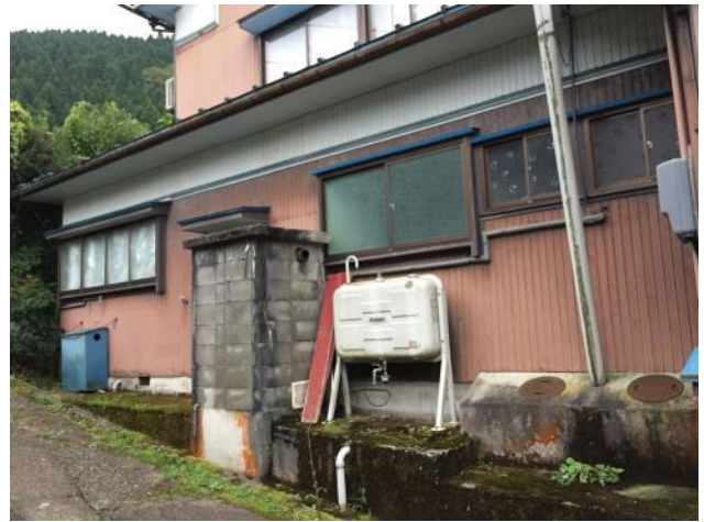
建物外観 (北側)
