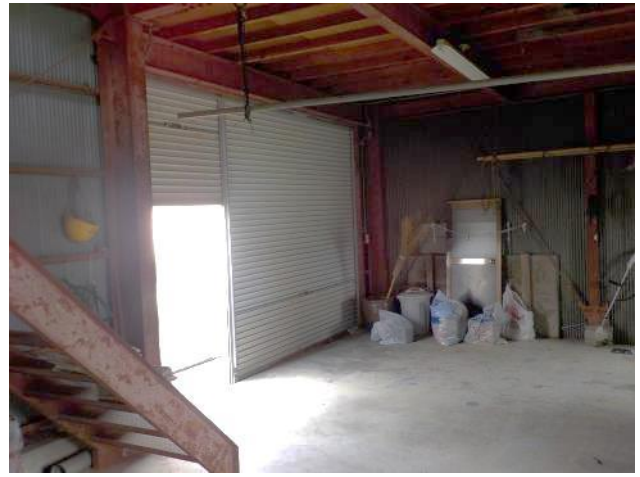
1階 東側シャッター付近
