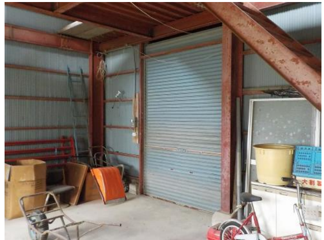
1階 西側シャッター付近
