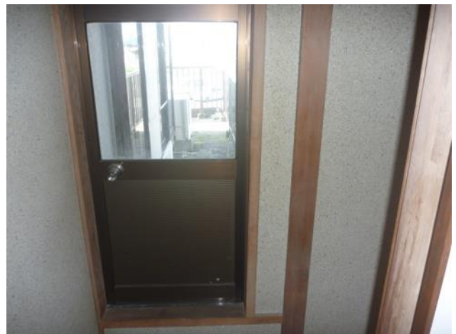
2階 北側ベランダ出入口
