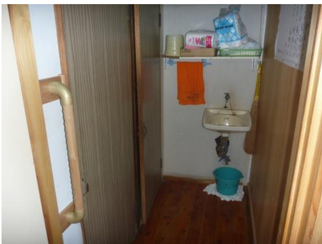
1階 トイレ手洗い場
