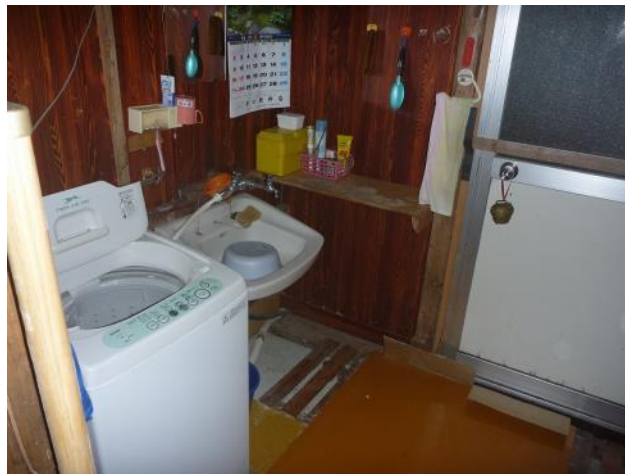
1階 洗濯機置場、洗面所、勝手口
