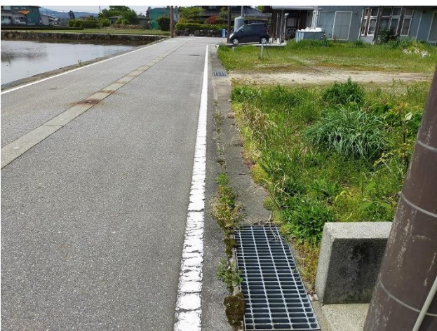
接道状況（南西方向）
